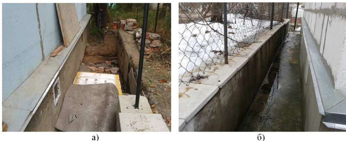
Рис. 2. Фото об'єкта з підсиленням запропонованим методом: а – під час виконання робіт; б – фото після 4 років експлуатації об'єкта
