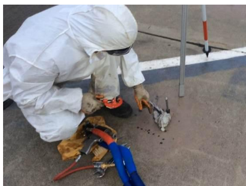
Рис. 3 – Работы по выравниванию плиты рулежной дорожки в аэропорту
