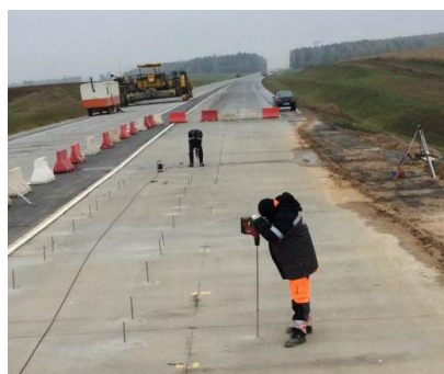
Рис. 4 – Работы по выравниванию плит дорожного полотна на участке 2-й МКАД
