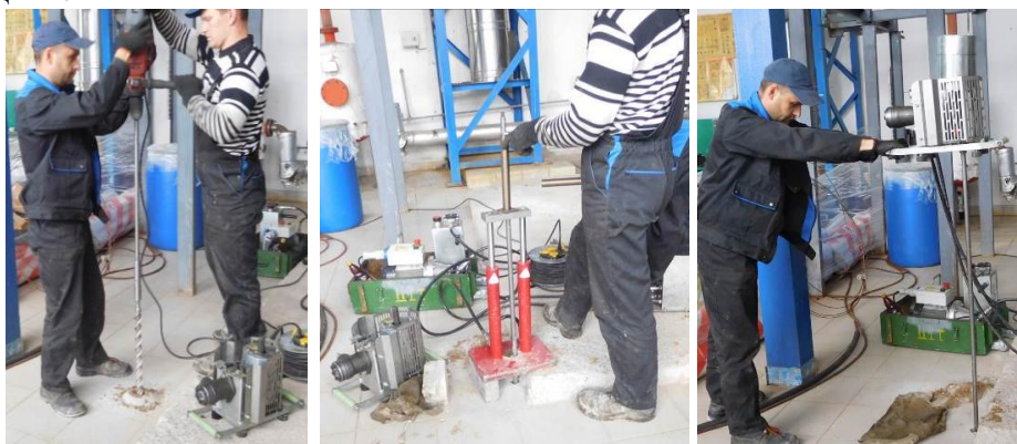
Рис. 2 – Проходка скважины внутри котельной СОО «Конте Спа» через высверленное отверстие в бетонном полу (а), извлечение штанг бура или зонда из скважины (б) и динамическое зондирование грунта в скважине (в)
