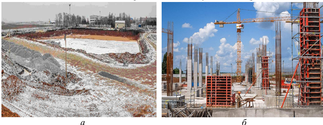
Рис. 7. Етапи будівництва споруд аеродрому:
