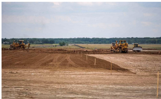
Рис. 5. Земляні роботи на території аеропорту: а – формування рельєфу згідно з проектом вертикального упорядкування; б – винесення на місцевість проектних відміток
