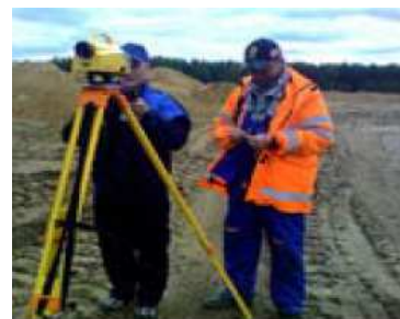
Рис. 5. Земляні роботи на території аеропорту: а – формування рельєфу згідно з проектом вертикального упорядкування; б – винесення на місцевість проектних відміток
