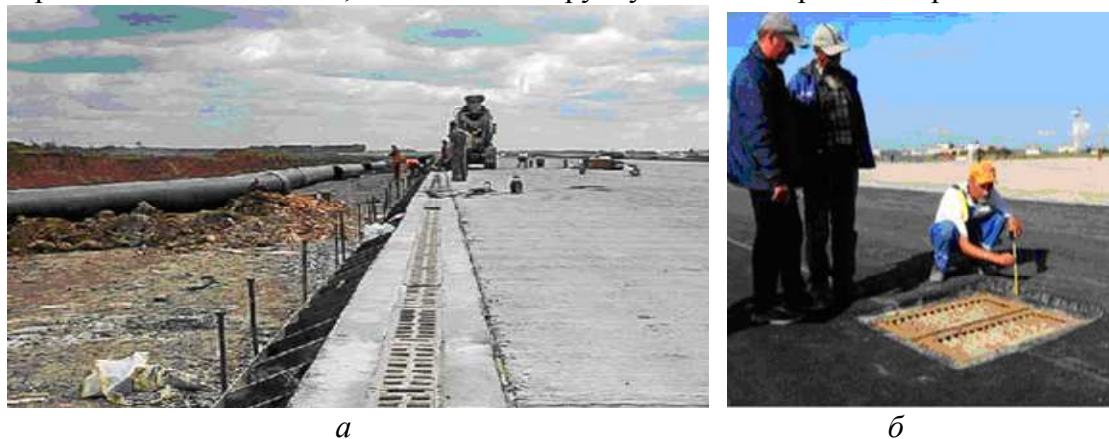
Рис. 8. Прокладання підземних комунікацій:
