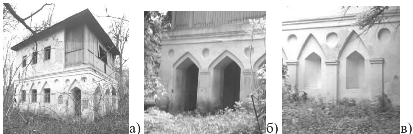
Рис. 2.26. Скарбниця в селі Тиниця (XVIII ст.): а) загальний вид; б) галерея з арками; в) аркові пласкі ніші
