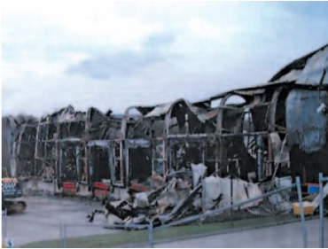
Рис. 5.7. Руйнування фасаду викликані пожежею: а) виділення їдконого диму; б) фото після пожежі; в), г) рух вогня зверху до низу; д) наслідки пожежі в Італії; е) те ж у Великобританії
