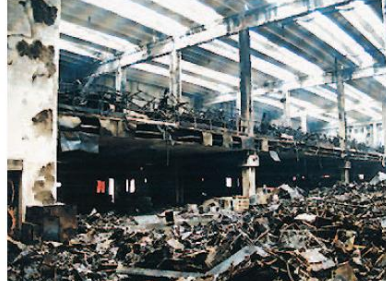
Рис. 5.7. Руйнування фасаду викликані пожежею: а) виділення їдконого диму; б) фото після пожежі; в), г) рух вогня зверху до низу; д) наслідки пожежі в Італії; е) те ж у Великобританії
