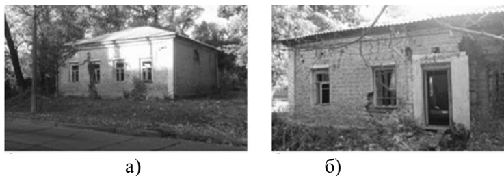
Рис. 2.35. Газова котельня по вул. Щорса: а) – загальний вид; б) – тріщина, розкриття 1,5-2,5 см
