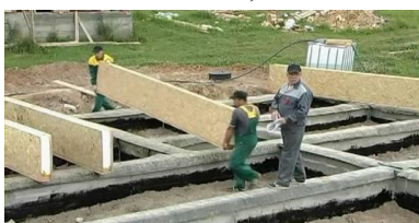
Рис. 5.12. Виготовлення дерев'яних сандвіч панелей: а) схема виготовлення ; б),в) виготовлення сандвіч панелей з OSB листів; г), д) обробка сандвіч панелей; е), ж) транспортування та монтаж
