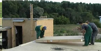
Рис. 5.12. Виготовлення дерев'яних сандвіч панелей: а) схема виготовлення ; б),в) виготовлення сандвіч панелей з OSB листів; г), д) обробка сандвіч панелей; е), ж) транспортування та монтаж
