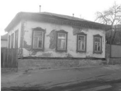
Рис. 2.42. Житловий будинок по вул. О. Десняка: а) загальний вид; б) деформації стіни та руйнування фундаменту; в), г) вид після підсилення фундаменту
