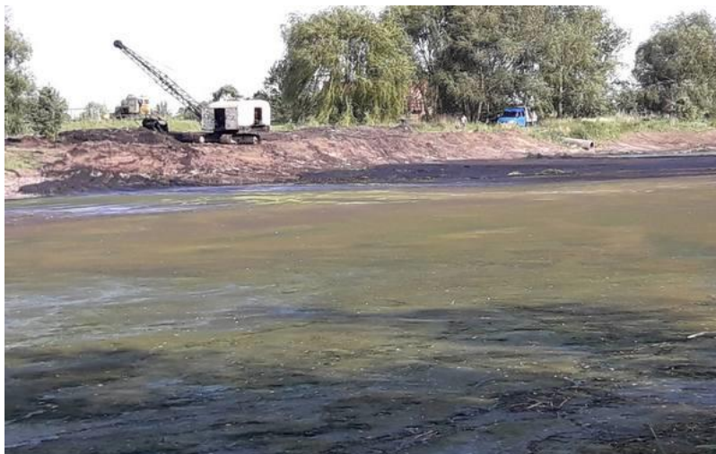
Рисунок 4.53 – Процес реконструкція біологічних ставків очисних споруд
