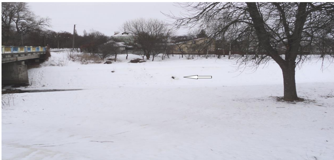
Рисунок 4.7 – Водовипуск ПК 1243+40 пр. берег
