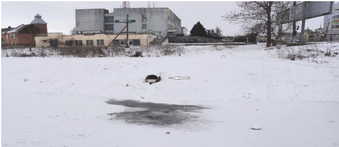
Рисунок 4.10 – Водовипуск ПК 1248+30 лів. берег (базарний міст)
