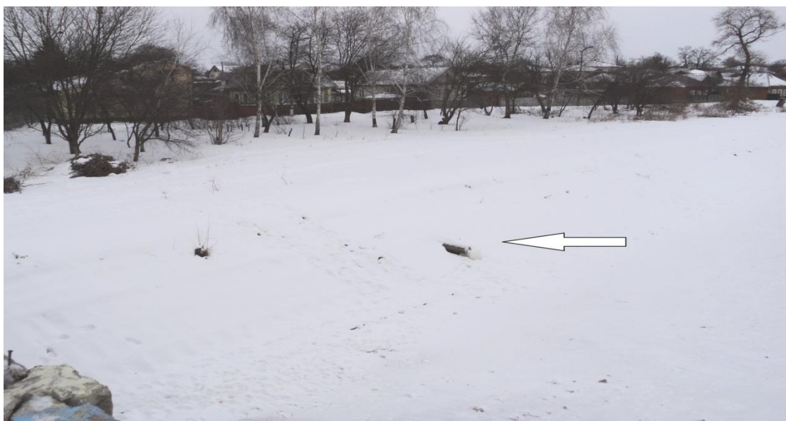
Рисунок 4.8 – Водовипуск ПК 1245 пр. берег
