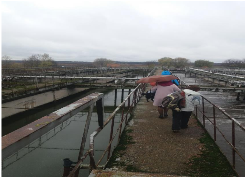
Рисунок 4.51 – Процес глибокої біологічної очистки за допомогою радіальної установки «Акватор»
