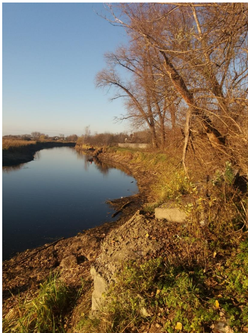
Рисунок 5.24 – Старі будівельні конструкції на узбережжі.
