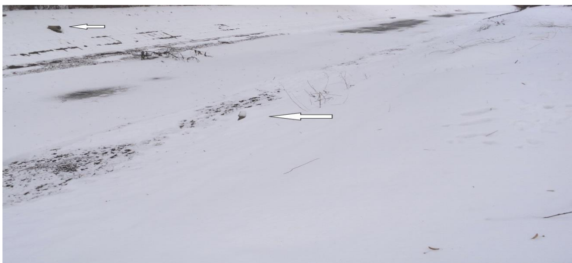
Рисунок 4.17 – Водовипуск ПК 1241, ПК 1240
