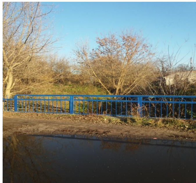
Рисунок 5.27 – Міст у Козельці через водовиток з очисних споруд до р. Остер.
