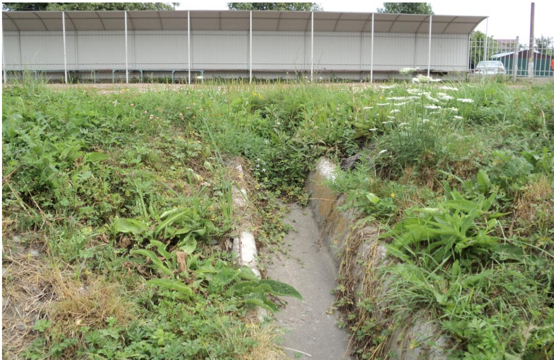
Рисунок 4.10 – Водовипуск ПК 1248+30 лів. берег (базарний міст) влітку
