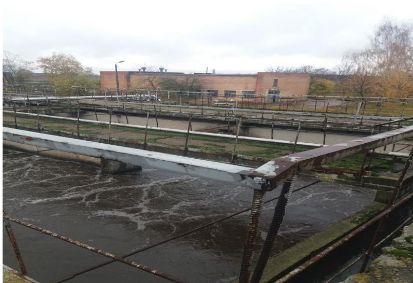
Рисунок 4.50 – Процес глибокої біологічної очистки за допомогою радіальної установки «Акватор»
