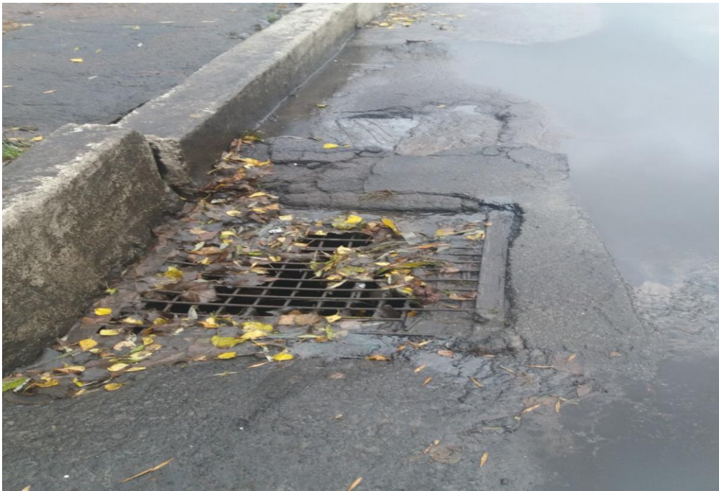
Рисунок 4.24 – Ливнева каналізація по вул. Набережна
