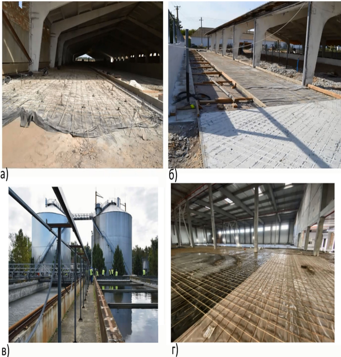
Рисунок 1. Застосування композитної арматури ТОВ «ІМПЕРАТИВ ЮА»: а)-б) свинокомплекс; в) станція очистки стічних вод, Угорщина, м. Вац; г) фабрика іграшок
