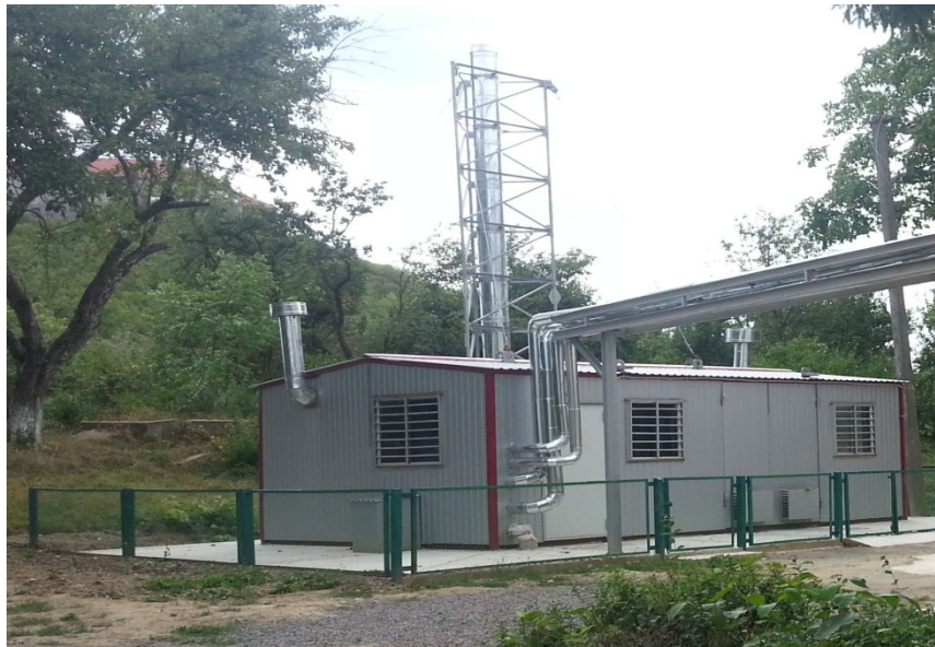
Рисунок 1 – Встановлення модульної твердопаливної котельні в м. Мукачеве для ЗОШ №6
