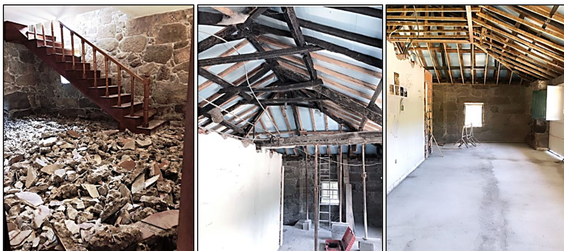
Рисунок 3 – Процес реконструкції приміщень
