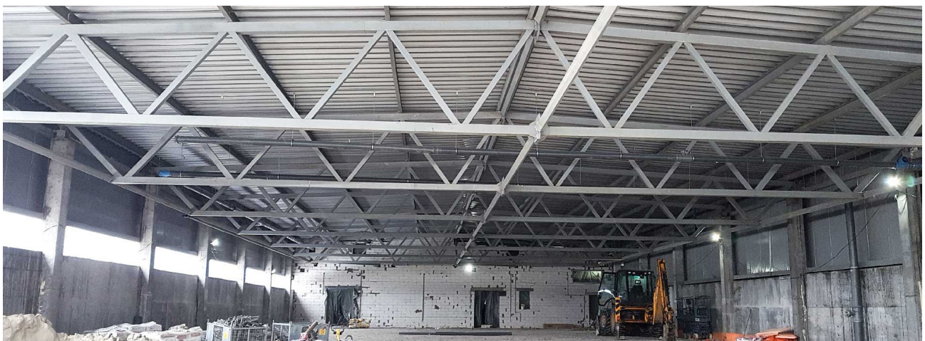
Рисунок 3 – Металеві ферми, що влаштовано по залізобетонним колонам
