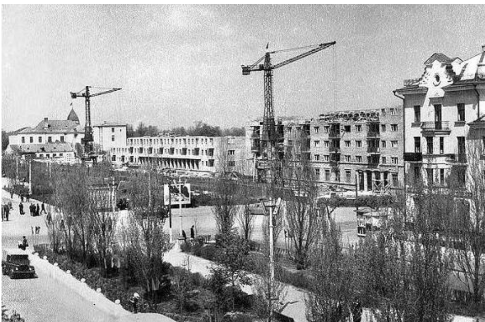
Рис. 1. Світлини 1961 року, на яких зафіксовано процес будівництва готелю «Україна»
