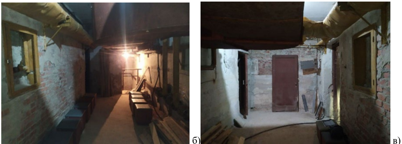
Рис. 1 – Приміщення: а) вхід в укриття; б, в) – кімната укриття
