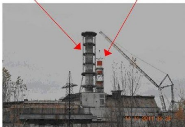
Рис.1. Існуюча вентиляційна труба ВТ-2 та нова вентиляційна труба НВТ-2 ЧАЕС, джерело [3]
