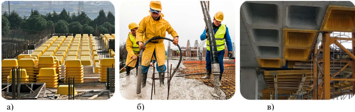
Рис. 2. Кесонне перекриття: а) кесонна опалубка; б) бетонування; в) загальний вид
