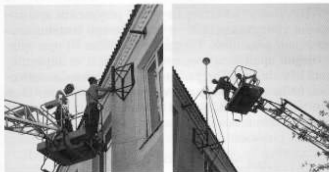
Мал. 2. Процес монтування опори
