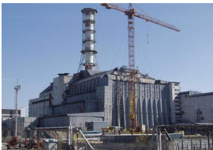
Рис.6.1. Изоляционное сооружение над четвёртым энергоблоком Чернобыльской атомной электростанции
