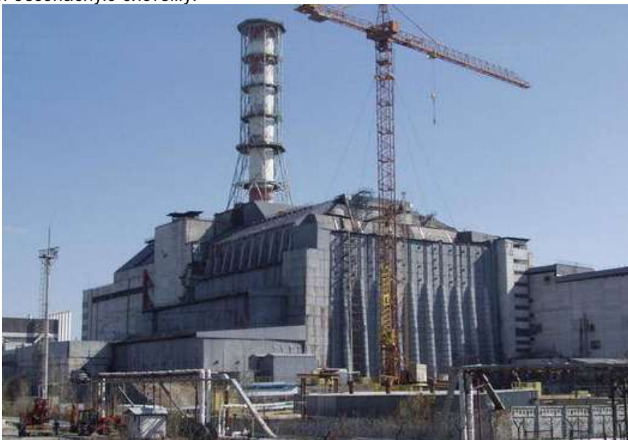
Рис. 1. Изоляционное сооружение над четвертым энергоблоком Чернобыльской атомной электростанции
