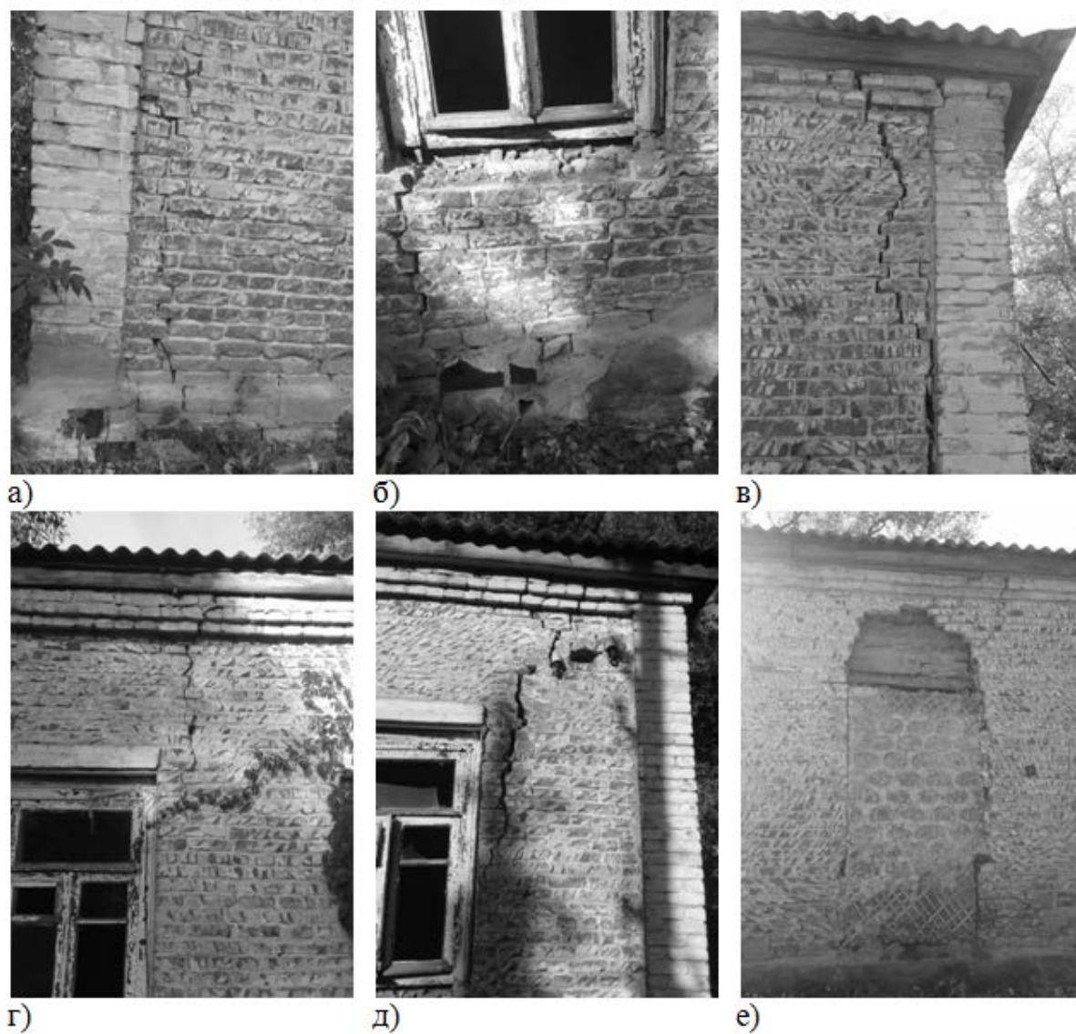
Рис. 12.38 – Деформації будинку
