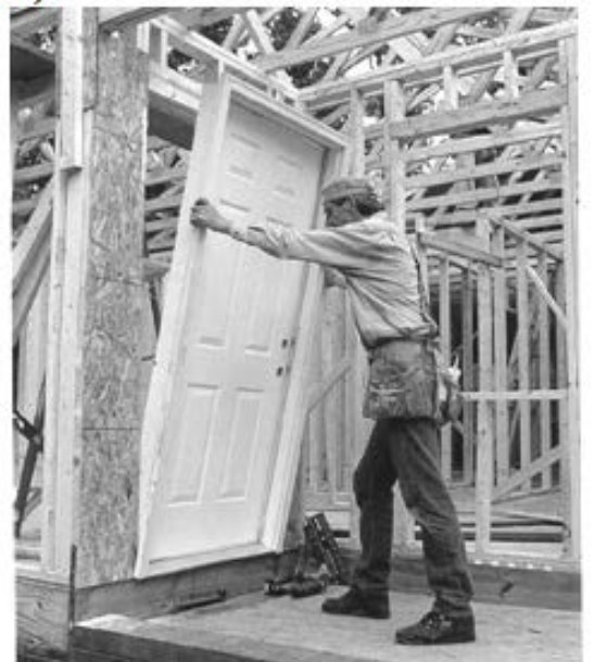
Рис. 3.10 – Захист будинку: а) – оздоблення сайдингом; б) – влаштування гідроізоляційного покриття; в) – влаштування утеплення; г) – влаштування дверного пакету
