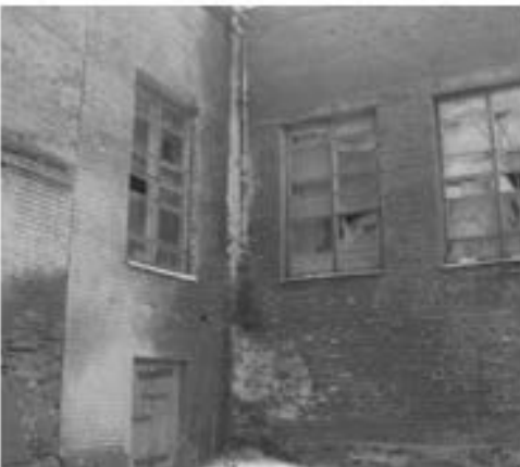
Рис. 12.54 – Руйнування старих казарм по вул. Стрілецькій: а) – вид взимку, 2010 р.; б) – вид навесні 2011 р.; в), г) – зволоження стіни будівлі; д) – обрушення кладки; е) – обрушення зовнішнього кута будинку; ж) – зволоження кута будинку; к) – обрушення кладки внутрішнього кута будинку
