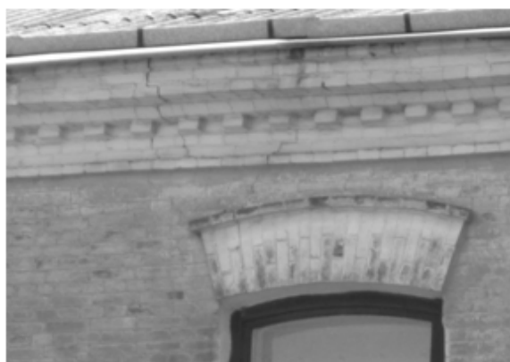
Рис. 12.43 – Деформування фасаду що виходить на подвір'я: а) – тріщина над лівим вікном другого поверху; б) – тріщини під правим вікном першого поверху, гарно видно замокання кута будівлі
