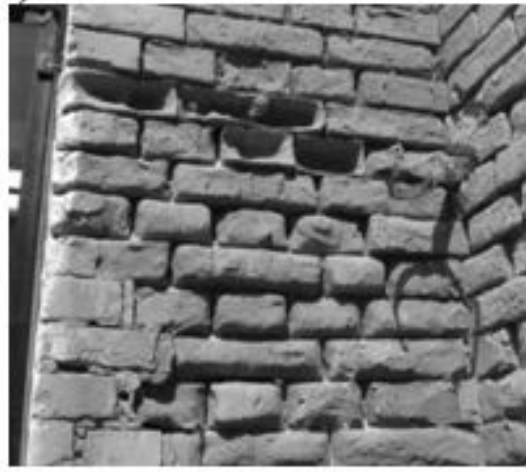
Рис. 12.52 – Навчальний корпус по вул. Стрілецькій: а) – головний фасад; б) – фасад що виходить на внутрішнє подвір'я; в) – кут будинку, що постійно зволожується; г), д), е) – вивітрювання цегли
