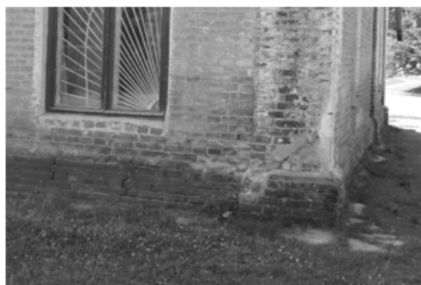
Рис. 12.43 – Деформування фасаду що виходить на подвір'я: а) – тріщина над лівим вікном другого поверху; б) – тріщини під правим вікном першого поверху, гарно видно замокання кута будівлі
