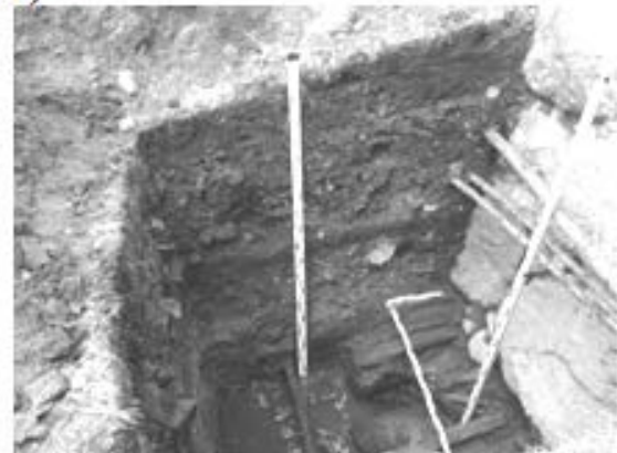
Рис. 5.13 – Укріплення ґрунту: а) – підшва фундаменту апсиди Борисоглібського собору в Чернігові; б) – церква Андрія в Переяслові, план; в) – сліди лежнів в апсиді церкви Михайла в Переяслові; г) – дубові лежні під фундаментом Борисоглібського собору в Новгороді; д), е) – дерев'яні субструкції в основі фундаменту Комендантського будинку на території Виборгського замку, Росія
