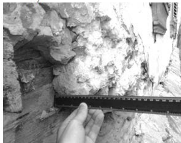
Рис. 7.30 – Зовнішні стіни: а) – кут будинку; б) – з'єднання колод стін; в) – шматки цегли в розчині; г) – розчин тримається на дерев'яних кілочках
