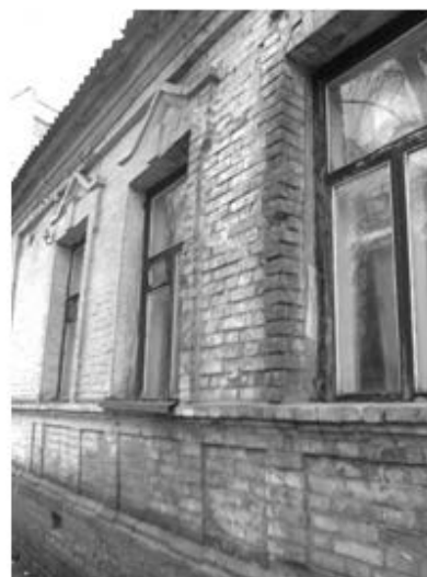
Рис. 12.31 – Руйнування будинків: а) тріщини розкриттям 0,8-1,2 см будинку №9; б) – випинання простінку будинку №13; в) – тріщина розкриттям
