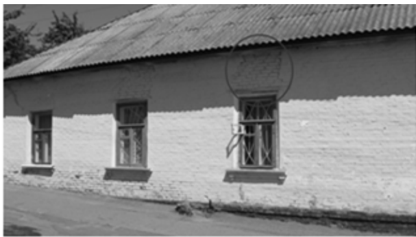
Рис. 12.46 – Фасад будинку, що виходить на вул. О. Десняка: а) – загальний вид; б) – тріщини над вікном
