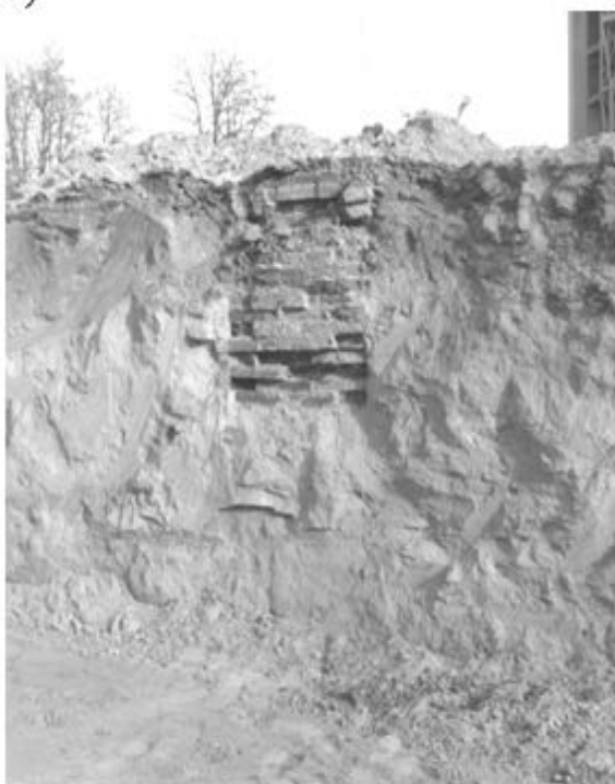
Рис. 5.62 – Дослідження підземної частини будинку челяді Леоніда Глібова: а) – загальний вид цокольної частини; б) – переріз цоколю; в) – загальний вид фундаменту в котловані при дослідженні; г) – розріз фундаменту
