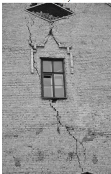
Рис. 12.57 – Клуб військової частини до перепланування: а), б) – загальний вид; в) – руйнування стіни першого поверху; г) – тріщина на третьому поверсі, вид ззовні; д) – тріщина на третьому поверсі, що проходить як несучі стіни так і плити перекриття, вид з приміщення
