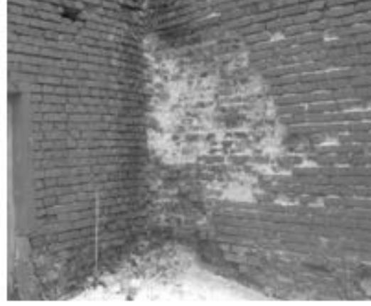
Рис. 12.54 – Руйнування старих казарм по вул. Стрілецькій: а) – вид взимку, 2010 р.; б) – вид навесні 2011 р.; в), г) – зволоження стіни будівлі; д) – обрушення кладки; е) – обрушення зовнішнього кута будинку; ж) – зволоження кута будинку; к) – обрушення кладки внутрішнього кута будинку
