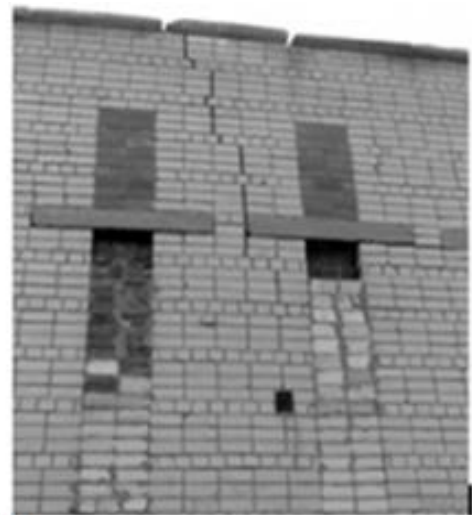
Рис. 12.36 – Газова котельня по вул. Щорса: а) – загальний вид; б) – тріщина, розкриття 1,5-2,5 см
