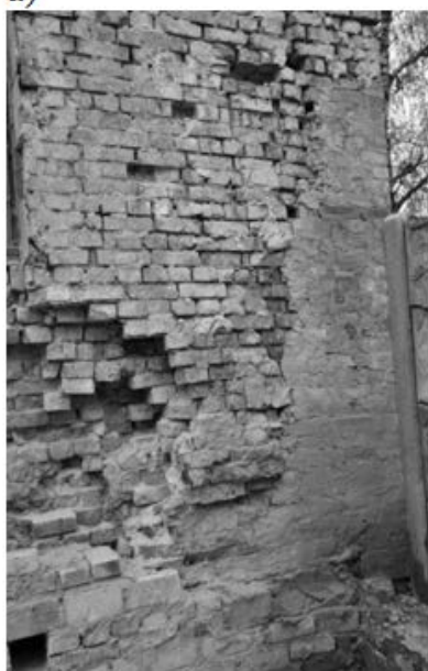
Рис. 12.57 – Клуб військової частини до перепланування: а), б) – загальний вид; в) – руйнування стіни першого поверху; г) – тріщина на третьому поверсі, вид ззовні; д) – тріщина на третьому поверсі, що проходить як несучі стіни так і плити перекриття, вид з приміщення
