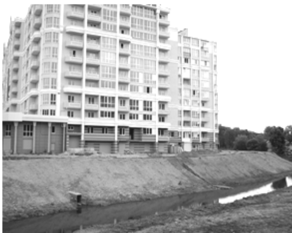
Рис. 5.15 – Будівництво на складних ділянках в Чернігові: а) – будівництво багатопверхового будинку на березі річки в центрі Чернігова, на насипних ґрунтах; б) – старий колодязь, що був виявлений при копанні котловану під будівництво багатопверхового житлового будинку по вул. Шевченка
