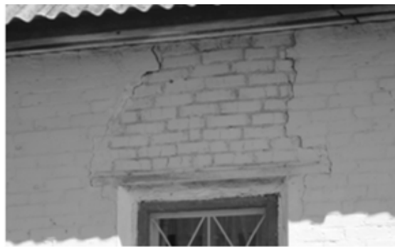
Рис. 12.46 – Фасад будинку, що виходить на вул. О. Десняка: а) – загальний вид; б) – тріщини над вікном
