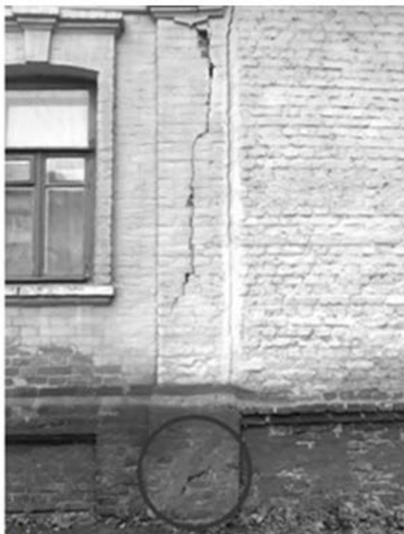
Рис. 12.28 – Руйнування елементів: а) – фундаменту; б) – стіни
