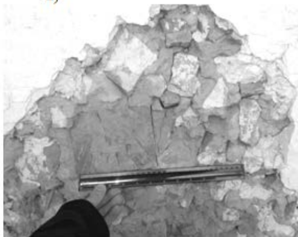
Рис. 7.30 – Зовнішні стіни: а) – кут будинку; б) – з'єднання колод стін; в) – шматки цегли в розчині; г) – розчин тримається на дерев'яних кілочках
