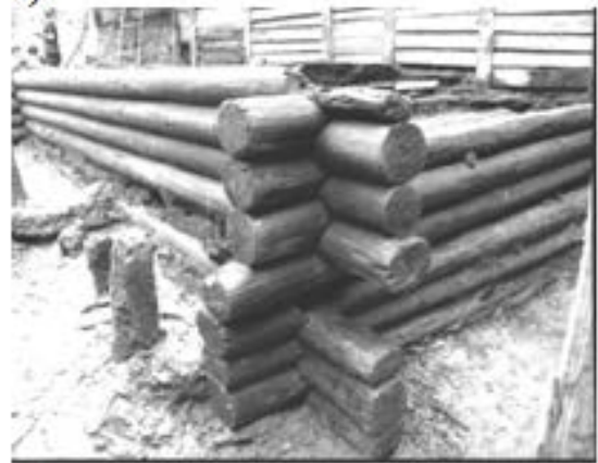
Рис. 5.1 – Дерев'яні будинки виявлені під час розкопок на Подолі в Києві в 1970-1972 роках: а) – дерев'яний зруб садиби X століття, побудований "в обло"; б) – фото з приватного архіву Г.Ю. Івакіна, археолога, який в 1970-тих роках працював у складі Київської археологічної експедиції Інституту археології; в) – нижня частина житлового зрубу на Подолі; г) – господарський зруб X ст. Поділ. 1972 р.; д) – під час розкопок; е) – дерев'яний зруб X століття, з'єднання колод
