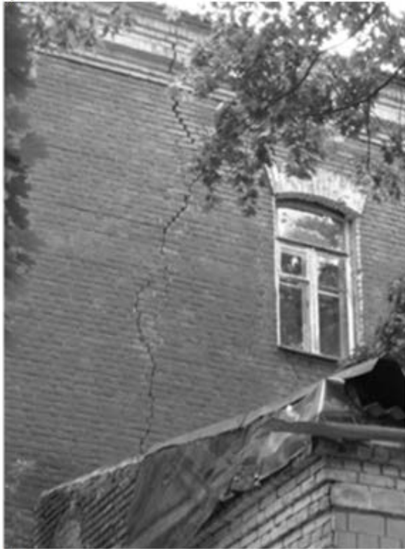
Рис. 12.55 – Руйнування старих казарм внаслідок значного зволоження стін та ґрунту: а) – значне зволоження стіни будинку; б), в), г) – розкол будинку навпіл внаслідок просідання ґрунту, який було значно зволожено
