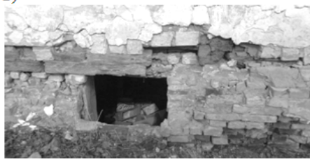
Рис. 7.26 – Деформації будинку: а) вид головного фасаду; б) – вид дворового фасаду; в) – руйнування над вікнами підвалу; г) – руйнування кута будинку; д), е) – деформації цокольної частини
