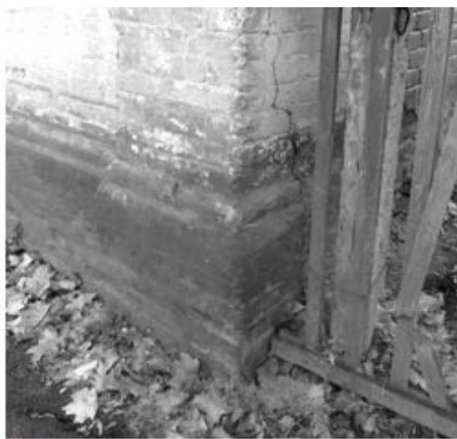
Рис. 12.30 – Замокання будинків: а) – кута будинку №9; б) – замокання стіни будинку №13
