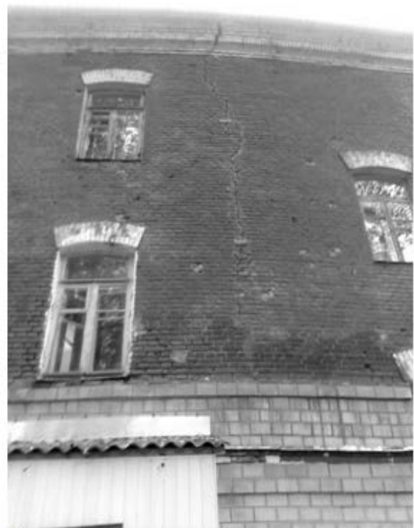
Рис. 12.55 – Руйнування старих казарм внаслідок значного зволоження стін та ґрунту: а) – значне зволоження стіни будинку; б), в), г) – розкол будинку навпіл внаслідок просідання ґрунту, який було значно зволожено
