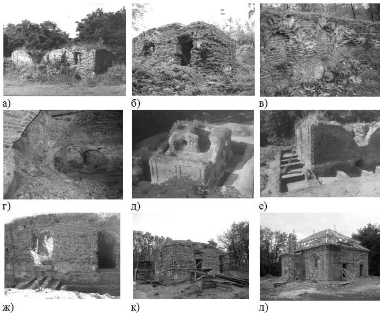
Рис. 7.12 – Кам'яниця П. Полуботка: а)-в) – вид до реставрації; г) – вид підвалу до реставрації; д) – вигляд з південного сходу; е)-ж) – під час дослідження фундаментів; к)-л) – реставраційні роботи.
