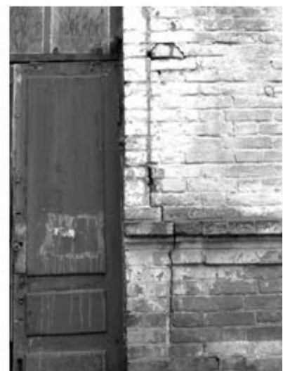
Рис. 12.31 – Руйнування будинків: а) тріщини розкриттям 0,8-1,2 см будинку №9; б) – випинання простінку будинку №13; в) – тріщина розкриттям
