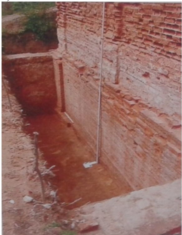
Рис. 7.13 – Фундаментно-підземна частина кам'яниці П. Полуботка: а)-в) – вид підвальної частини; г) – залишок металевої затяжки в стіні; д)-е) – вид фундаменту під час розкопок
