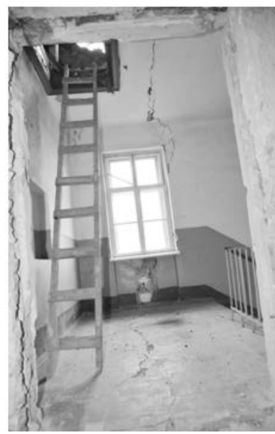
Рис. 12.57 – Клуб військової частини до перепланування: а), б) – загальний вид; в) – руйнування стіни першого поверху; г) – тріщина на третьому поверсі, вид ззовні; д) – тріщина на третьому поверсі, що проходить як несучі стіни так і плити перекриття, вид з приміщення
