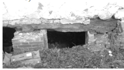
Рис. 7.26 – Деформації будинку: а) вид головного фасаду; б) – вид дворового фасаду; в) – руйнування над вікнами підвалу; г) – руйнування кута будинку; д), е) – деформації цокольної частини
