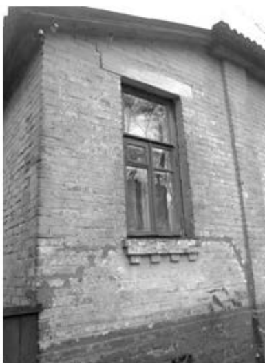
Рис. 12.31 – Руйнування будинків: а) тріщини розкриттям 0,8-1,2 см будинку №9; б) – випинання простінку будинку №13; в) – тріщина розкриттям
