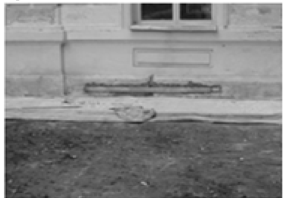
Рис. 5.36 – Хрещальня біля Спасо-Преображенського собору: а), б) – до ремонтних робіт; в), г) – місця виявлення тріщин; д), е), ж) – під час підсилення металевими затяжками; к) – металева затяжка; л) – підсилення металевою пластиною
