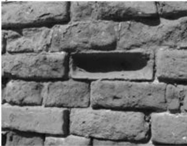
Рис. 12.52 – Навчальний корпус по вул. Стрілецькій: а) – головний фасад; б) – фасад що виходить на внутрішнє подвір'я; в) – кут будинку, що постійно зволожується; г), д), е) – вивітрювання цегли
