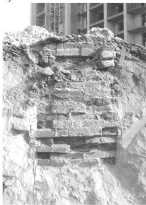
Рис. 5.62 – Дослідження підземної частини будинку челяді Леоніда Глібова: а) – загальний вид цокольної частини; б) – переріз цоколю; в) – загальний вид фундаменту в котловані при дослідженні; г) – розріз фундаменту
