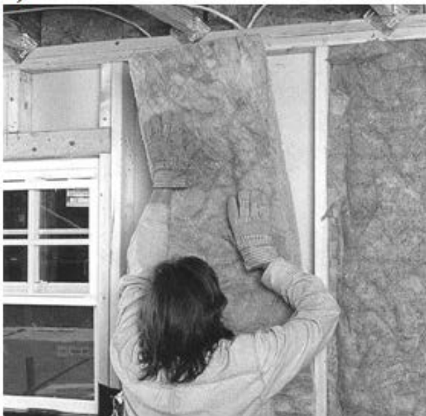
Рис. 3.10 – Захист будинку: а) – оздоблення сайдингом; б) – влаштування гідроізоляційного покриття; в) – влаштування утеплення; г) – влаштування дверного пакету
