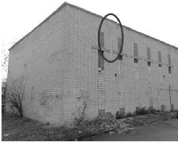
Рис. 12.36 – Газова котельня по вул. Щорса: а) – загальний вид; б) – тріщина, розкриття 1,5-2,5 см
