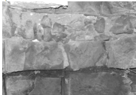
Рис. 7.27 – Підвальна частина будинку Дараган: а) – загальний вид; б) – фундамент печі; в) – цегляна підготовка під фундаментом печі; г) – цегляний бій між рядами кладки в стінах підвалу
