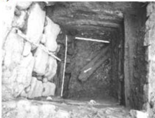
Рис. 5.13 – Укріплення ґрунту: а) – підшва фундаменту апсиди Борисоглібського собору в Чернігові; б) – церква Андрія в Переяслові, план; в) – сліди лежнів в апсиді церкви Михайла в Переяслові; г) – дубові лежні під фундаментом Борисоглібського собору в Новгороді; д), е) – дерев'яні субструкції в основі фундаменту Комендантського будинку на території Виборгського замку, Росія
