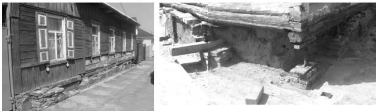
Рис. 12.48 – Заміна фундаменту дерев'яного будинку: а) – загальний вид будинку; б) – встановлення будинку на домкрати та заміна старої цегляної кладки на нову
