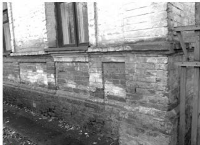
Рис. 12.30 – Замокання будинків: а) – кута будинку №9; б) – замокання стіни будинку №13
