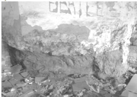
Рис. 7.27 – Підвальна частина будинку Дараган: а) – загальний вид; б) – фундамент печі; в) – цегляна підготовка під фундаментом печі; г) – цегляний бій між рядами кладки в стінах підвалу
