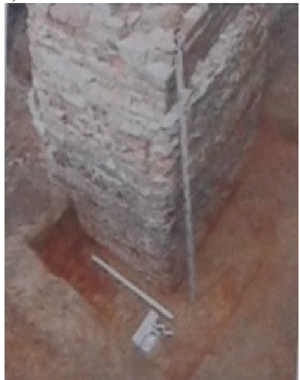
Рис. 7.13 – Фундаментно-підземна частина кам'яниці П. Полуботка: а)-в) – вид підвальної частини; г) – залишок металевої затяжки в стіні; д)-е) – вид фундаменту під час розкопок
