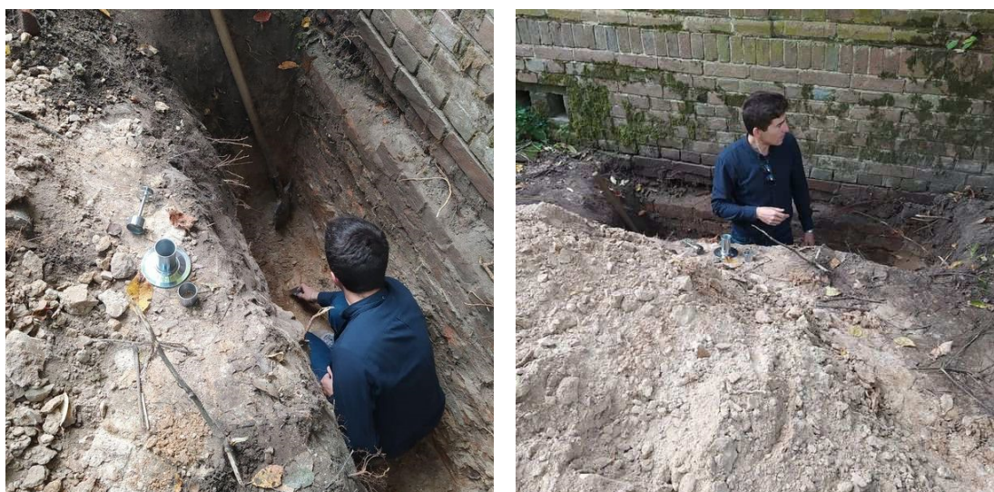
Рис. 1.2 – Дослідження ґрунту під подошвою фундаменту
