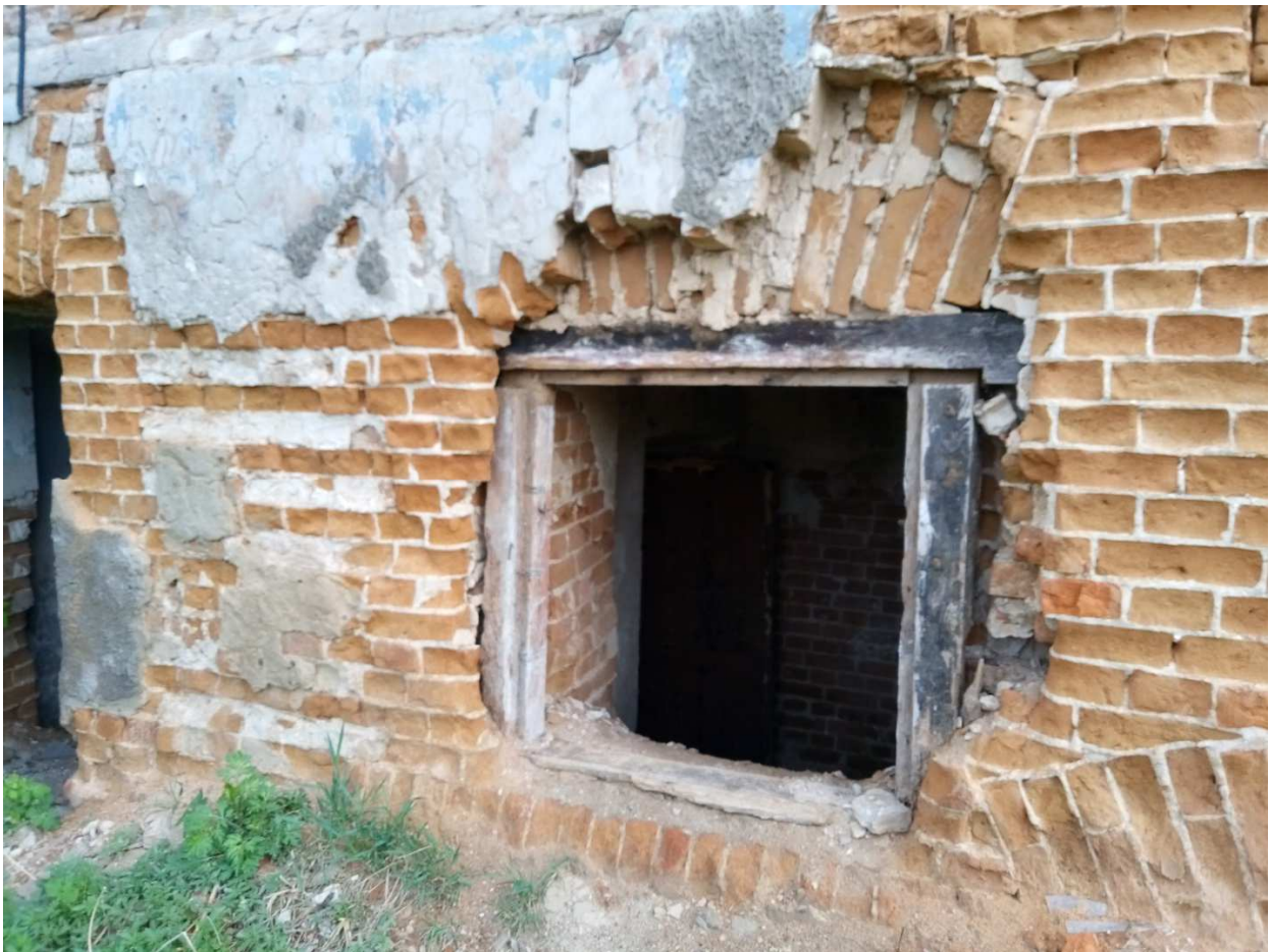
Рис. 2.3 – Вивітрювання кладки та випадіння перемички цегляної стіни
