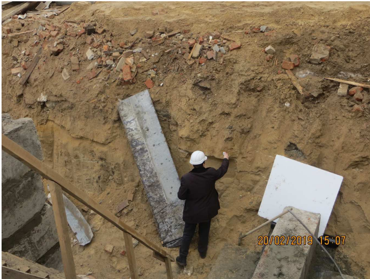
Рис. 1.3 – Дослідження ґрунтів у котловані
