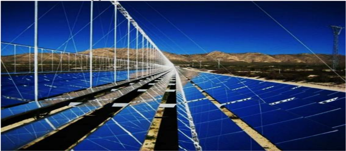
Рис.1 – Лінійний колектор Френеля [2]
